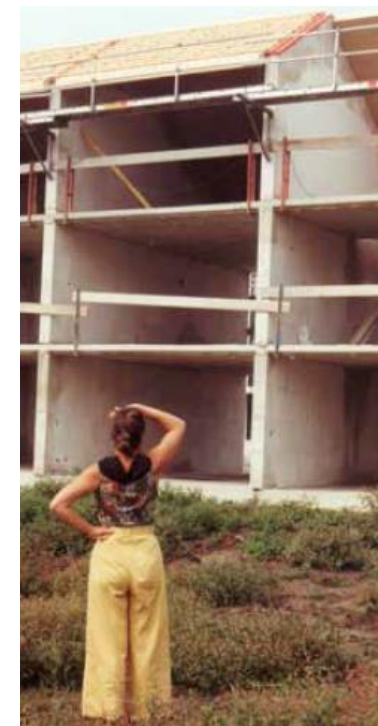
H: foto van de bouw van Het Groene Dak, GroeneDak.nl
