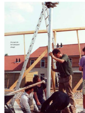
G: foto van de bouw van het projecthuis van Het Groene Dak, GroeneDak.nl
